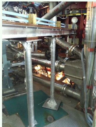
चित्र 10: रिफ्लेक्टोमेट्री के लिए समर्थन संरचना
